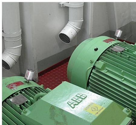
Les moteurs électriques d'ABB sont équipés de graisseurs simalube de 60 ml.
