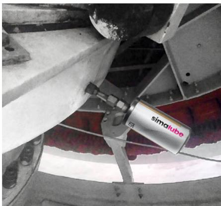
Dans cette éolienne, le graisseur simalube est réglé sur une durée de distribution de six mois.
