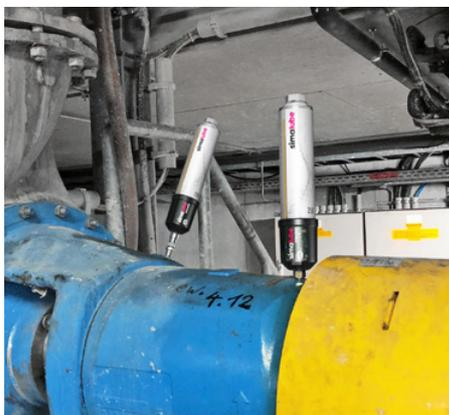
Die Lager der Pumpe werden mit zwei IMPULSE und simalube 250 ml geschmiert.
