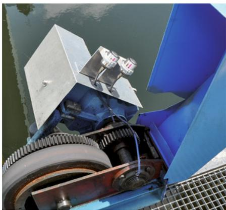
Lagerschmierung mittels Schläuchen an einem Nachklärbeckenräumer.
