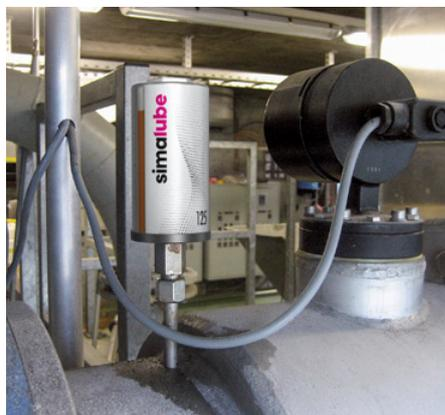
Lagerschmierung: Über ein kurzes Rohr wird der Schmierstoff zum Lager geführt.
