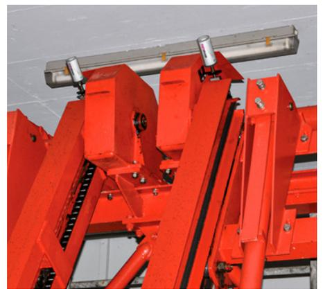
Kettenschmierung am Grobrechen mit simalube, ausgerüstet mit Bürsten.
